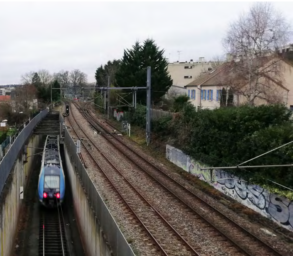
Le saut-de-mouton Rive droite où se croisent les trains pour Versailles rive droite (en dessous) et la ligne U (au-dessus).
